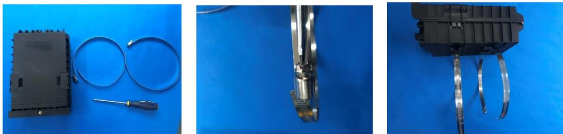
7.2.1 Установите муфту на опору. Затяните червячные замки с необходимым усилием для надежной фиксации муфты на опоре.
