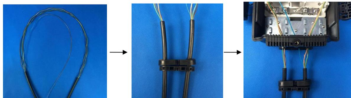
4.3.3 Закрепите кабель металлическим хомутом, закрепите ЦЭ в фиксаторе и выложите запас оптических модулей в лотке.
